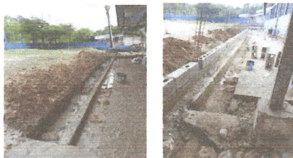
Foto 5: RECONSTRUCCIÓN DE MURO DE CONTENCIÓN. PARA PATIO DE ÁREA DE RECREACIÓN.
