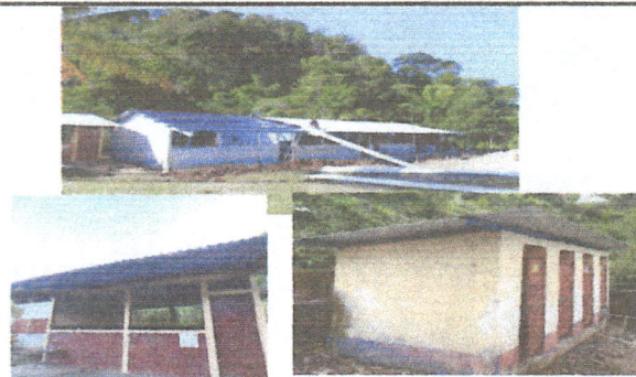
Foto 2: CAMBIO DE LÁMINA DE AULAS, COCINA Y BAÑOS.
