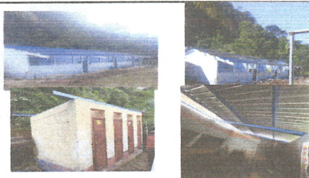
Foto 1: MANTENIMIENTO DE ESTRUCTURA METÁLICA, AULAS, BAÑOS Y COCINA.
