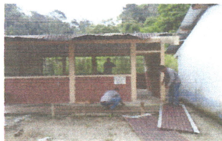
Foto 6: ENTORTADO DE CORREDOR Y COCINA
